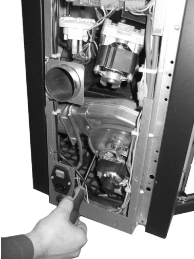
Fig. 103 - Fume fan cleaning: phase1
